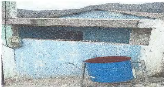
Foto 3: Sustrucion se ventana valcon
