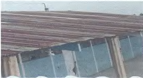
Foto 3: Sustrucción de chapas más tubular y perforación de pared
