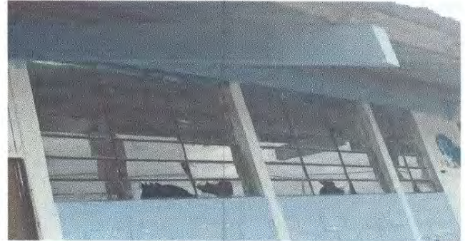
Foto 4: Sustrucción de vidrios
