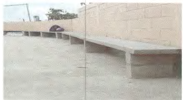
Foto 4: Reparacion de plancha de concreto de patio
