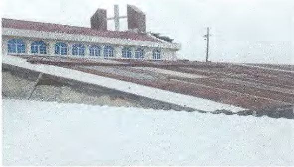
Foto 1: Sustrucción de lamina al modulo de aulas
