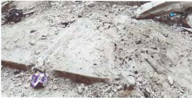
Foto1: Sustrucción de piso de concreto
